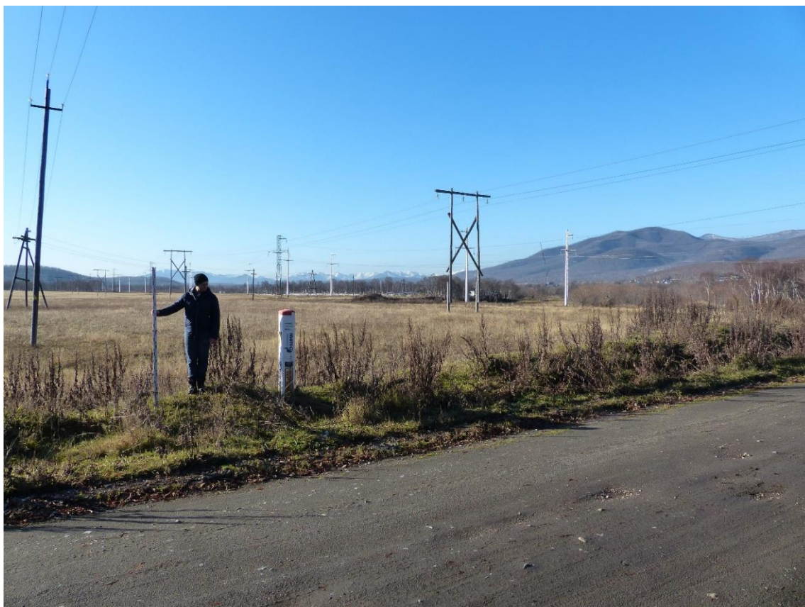
Рис. 25. Участок трассы газопровода. Вид с северо-востока.
