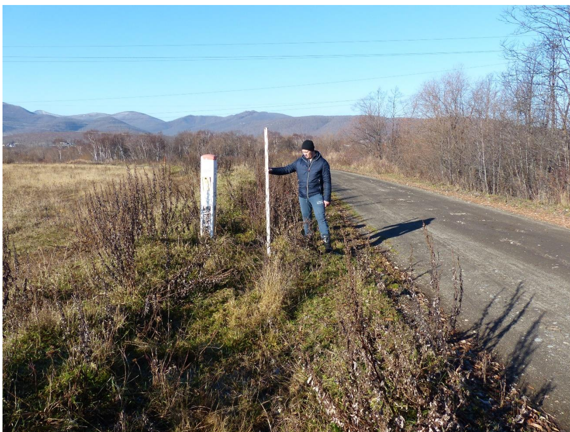
Рис. 23. Участок трассы газопровода. Вид с юго-востока.
