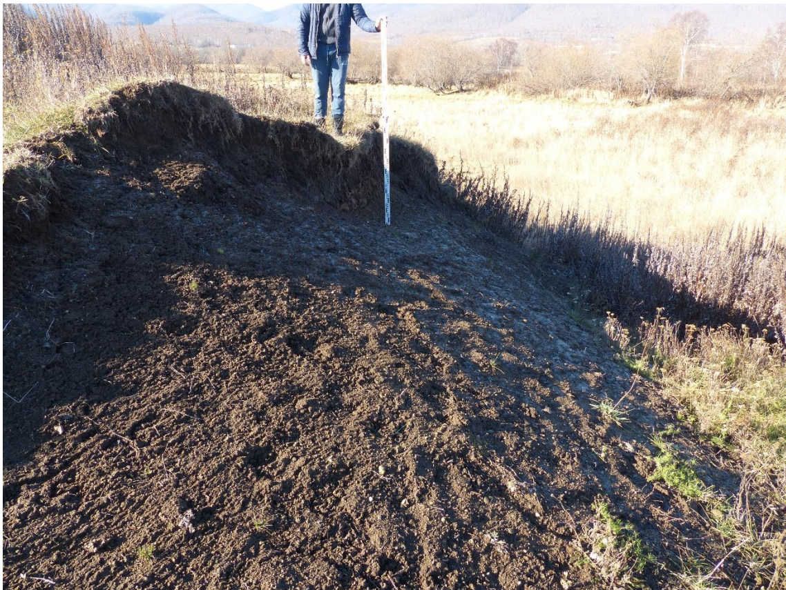
Рис. 48. Осмотр обнажения на трассе Объекта. Вид с северо-востока.
