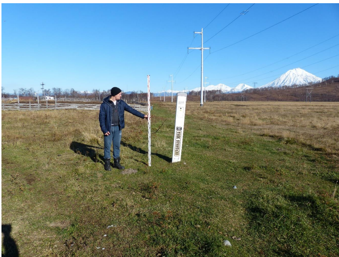
Рис. 38. Участок существующего газопровода на трассе Объекта. Вид с юго-запада.
