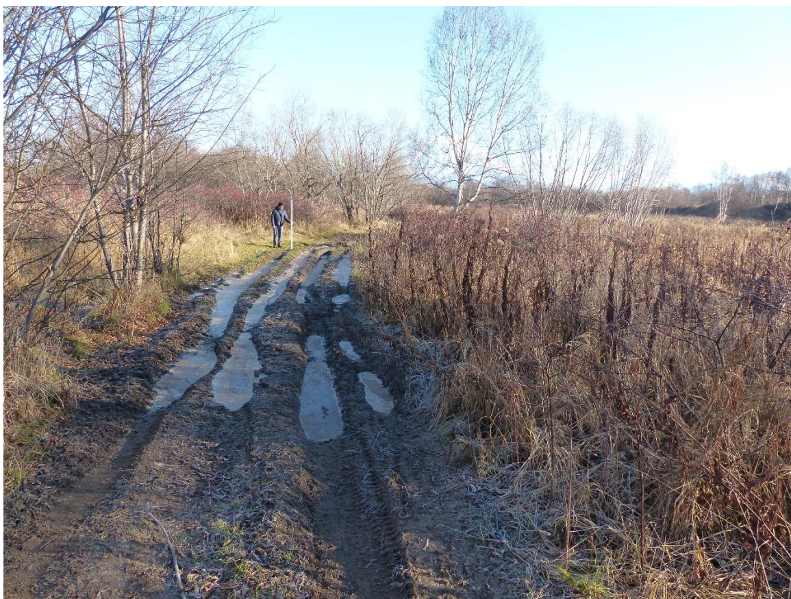
Рис. 15. Дорожная колея, заполненная водой. Вид с юга.
