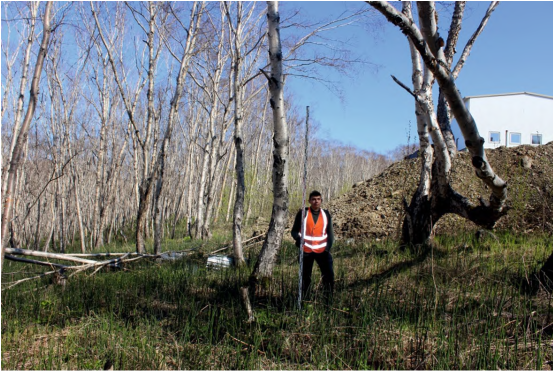
Рис. 75. «Объездная дорога от Петропавловское шоссе до жилого района «Северо-Восток». Строительство объездной дороги от проспекта Циолковского до Северо-Восточного шоссе (объезд Северо-Восточной части города)». Северо-восточная окраина г. Петропавловск-Камчатский, покаты́й склон возвышенности. Точка фотофиксации № 19 (вид с северо-запада).
