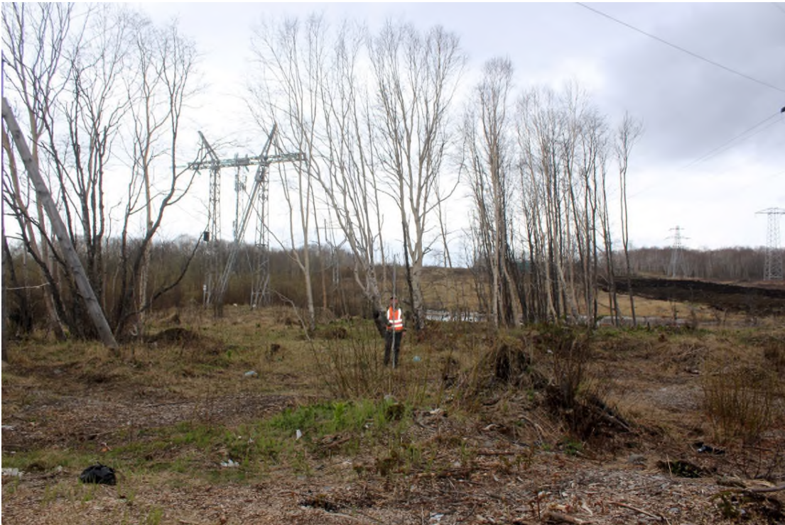
Рис. 14. «Объездная дорога от Петропавловское шоссе до жилого района «Северо-Восток». Строительство объездной дороги от проспекта Циолковского до Северо-Восточного шоссе (объезд Северо-Восточной части города)». Северо-восточная окраина г. Петропавловск-Камчатский, обводненный участок подножия возвышенности. Техногенно-преобразованный ландшафт - ЛЭП. Точка фотофиксации № 4. (вид с востока).
