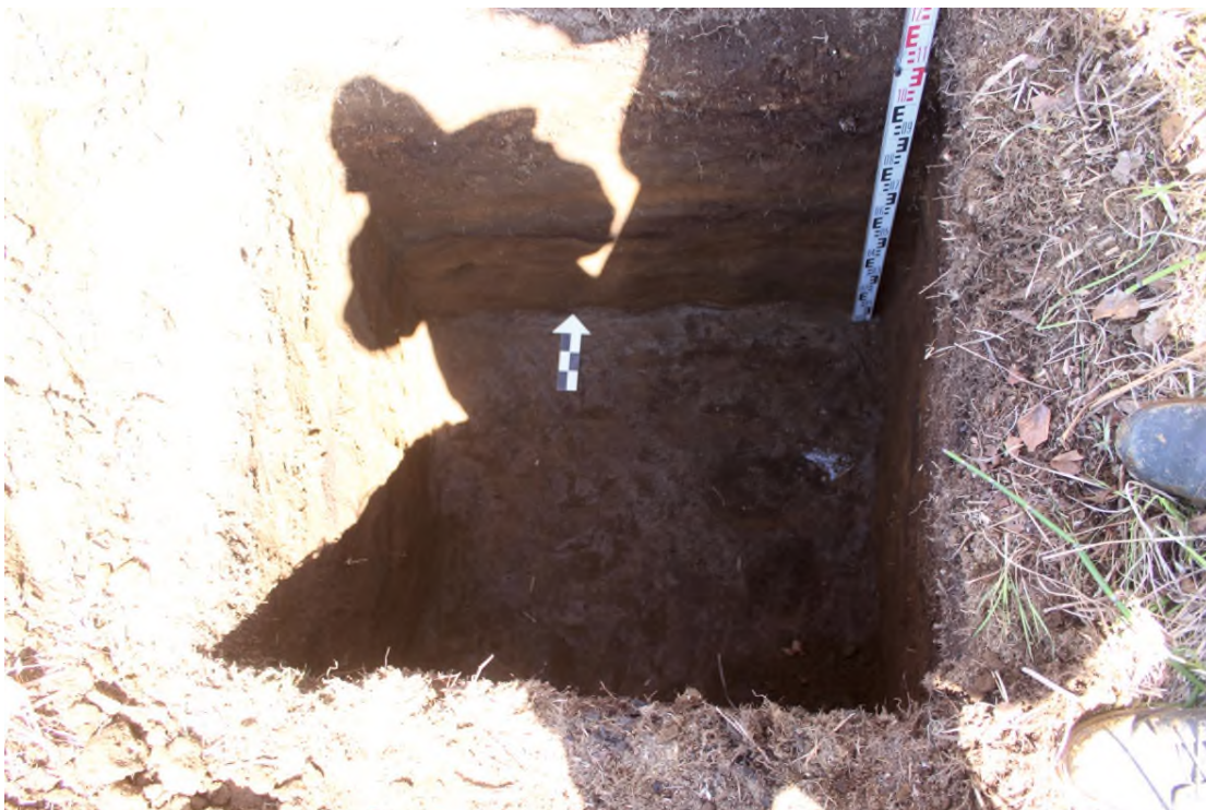
Рис. 46. «Объездная дорога от Петропавловское шоссе до жилого района «Северо-Восток». Строительство объездной дороги от проспекта Циолковского до Северо-Восточного шоссе (объезд Северо-Восточной части города)». Шурф № 5. Шурф с выбранным заполнением (вид с юга).
