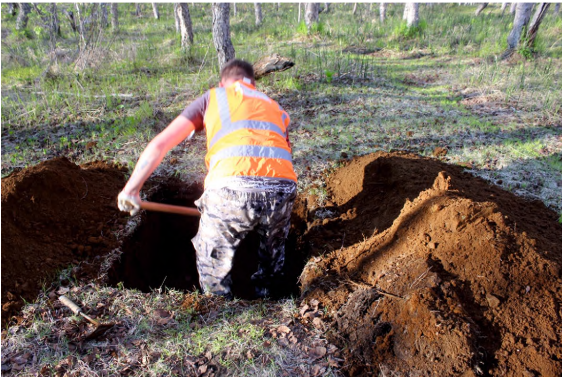
Рис. 78. «Объездная дорога от Петропавловское шоссе до жилого района «Северо-Восток». Строительство объездной дороги от проспекта Циолковского до Северо-Восточного шоссе (объезд Северо-Восточной части города)». Шурф № 9. Разборка заполнения шурфа (рабочий момент; вид с юга).
