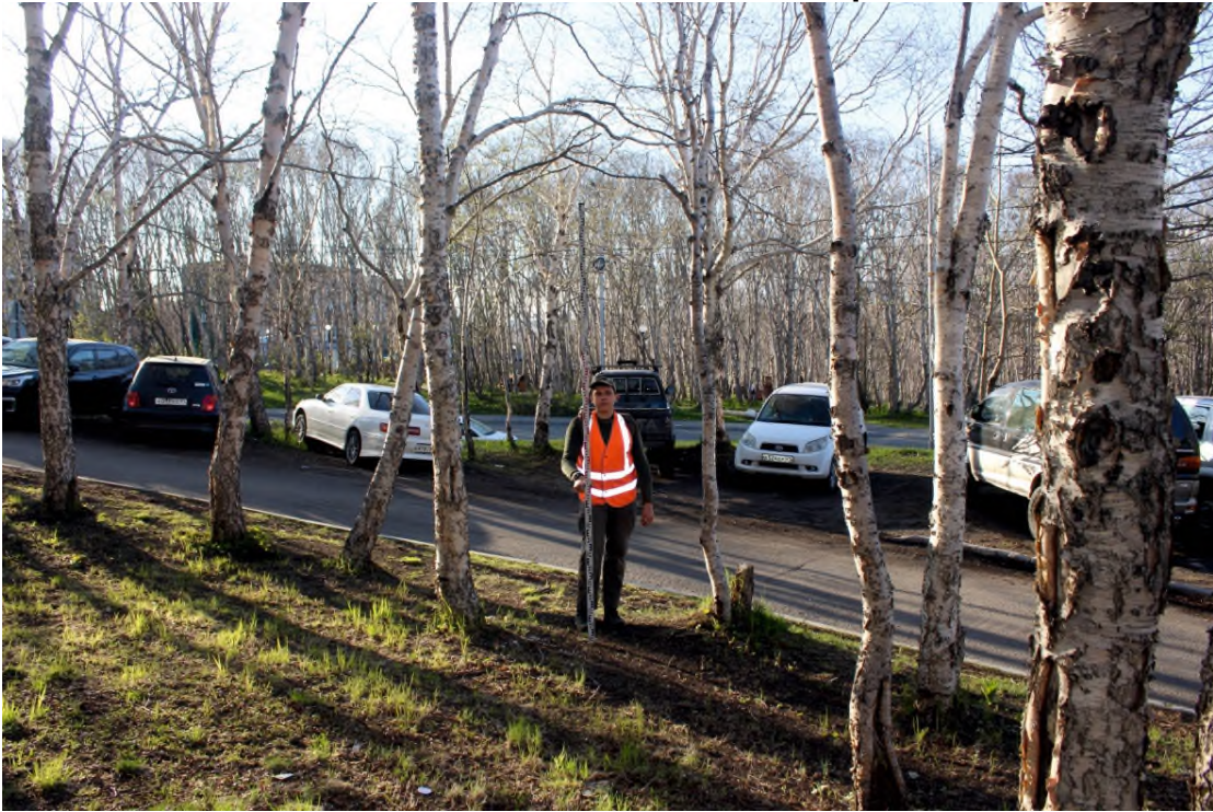
Рис. 89. «Объездная дорога от Петропавловское шоссе до жилого района «Северо-Восток». Строительство объездной дороги от проспекта Циолковского до Северо-Восточного шоссе (объезд Северо-Восточной части города)». Северо-восточная часть г. Петропавловск-Камчатский. Техногенно-преобразованный ландшафт - городская застройка. Точка фотофиксации № 21 (вид с юго-востока).
