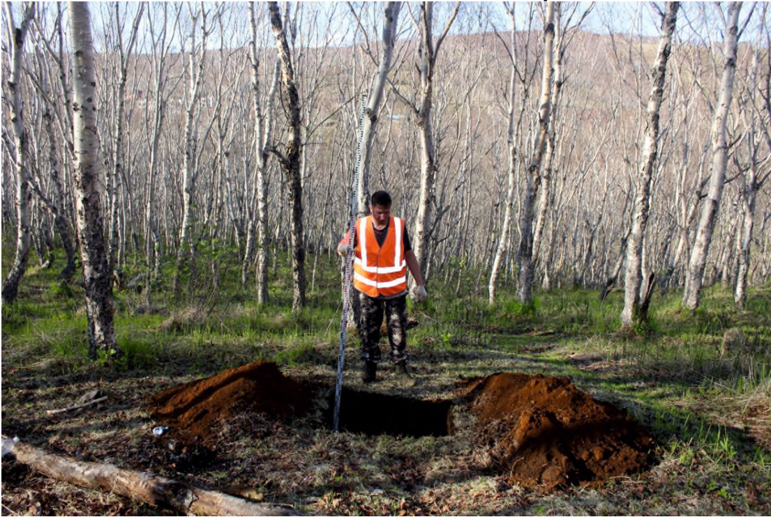
Рис. 81. «Объездная дорога от Петропавловское шоссе до жилого района «Северо-Восток». Строительство объездной дороги от проспекта Циолковского до Северо-Восточного шоссе (объезд Северо-Восточной части города)». Шурф № 9. Общий вид шурфа с выбранным заполнением (вид с юга).
