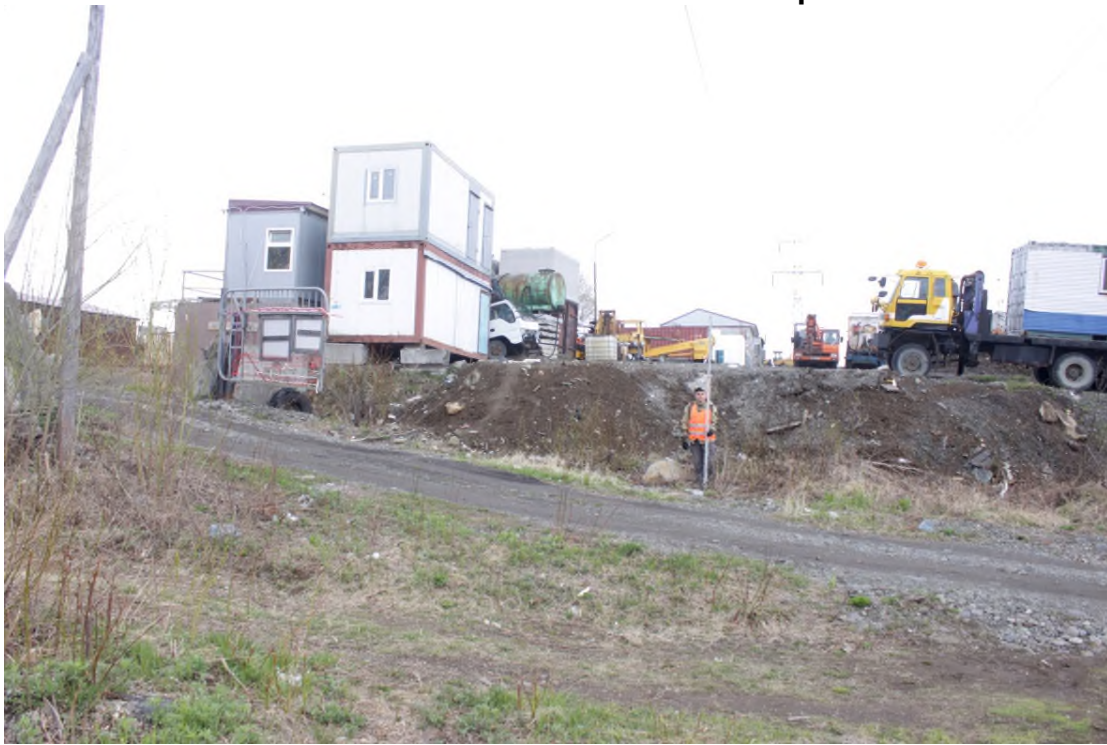
Рис. 15. «Объездная дорога от Петропавловское шоссе до жилого района «Северо-Восток». Строительство объездной дороги от проспекта Циолковского до Северо-Восточного шоссе (объезд Северо-Восточной части города)». Северо-восточная окраина г. Петропавловск-Камчатский, покатый склон возвышенности. Техногенно-преобразованный ландшафт - грунтовая дорога, площадка с постройками. Точка фотофиксации № 4 (вид с северо-запада).
