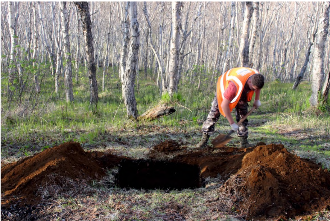
Рис. 84. «Объездная дорога от Петропавловское шоссе до жилого района «Северо-Восток». Строительство объездной дороги от проспекта Циолковского до Северо-Восточного шоссе (объезд Северо-Восточной части города)». Шурф № 9. Рекультивация шурфа (рабочий момент; вид с юга).
