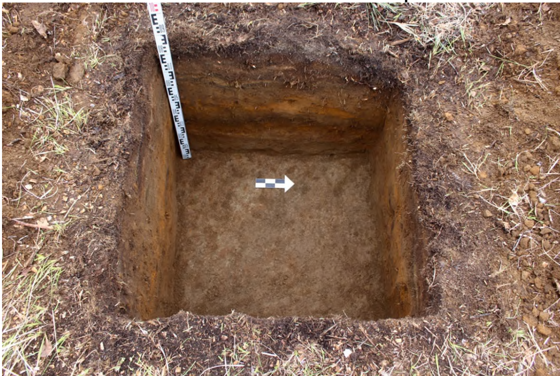
Рис. 11. «Объездная дорога от Петропавловское шоссе до жилого района «Северо-Восток». Строительство объездной дороги от проспекта Циолковского до Северо-Восточного шоссе (объезд Северо-Восточной части города)». Шурф № 1. Шурф с выбранным заполнением (вид с востока).
