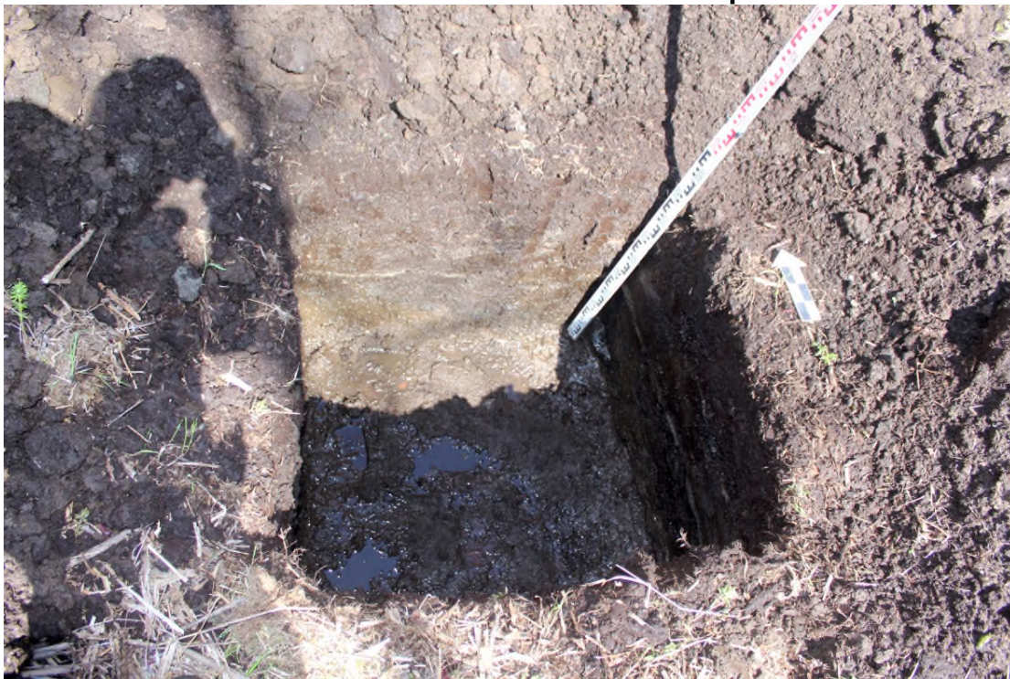
Рис. 55. «Объездная дорога от Петропавловское шоссе до жилого района «Северо-Восток». Строительство объездной дороги от проспекта Циолковского до Северо-Восточного шоссе (объезд Северо-Восточной части города)». Шурф № 6. Шурф с выбранным заполнением (вид с юга).
