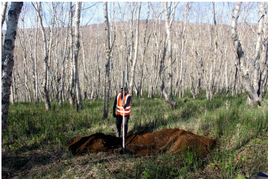
Рис. 70. «Объездная дорога от Петропавловское шоссе до жилого района «Северо-Восток». Строительство объездной дороги от проспекта Циолковского до Северо-Восточного шоссе (объезд Северо-Восточной части города)». Шурф № 8. Общий вид шурфа с выбранным заполнением (вид с юга).
