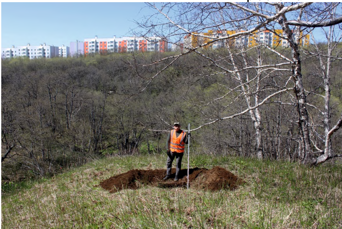
Рис. 45. «Объездная дорога от Петропавловское шоссе до жилого района «Северо-Восток». Строительство объездной дороги от проспекта Циолковского до Северо-Восточного шоссе (объезд Северо-Восточной части города)». Шурф № 5. Общий вид шурфа с выбранным заполнением (вид с севера).
