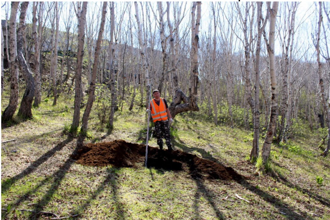
Рис. 65. «Объездная дорога от Петропавловское шоссе до жилого района «Северо-Восток». Строительство объездной дороги от проспекта Циолковского до Северо-Восточного шоссе (объезд Северо-Восточной части города)». Шурф № 7. Общий вид шурфа с выбранным заполнением (вид с востока).
