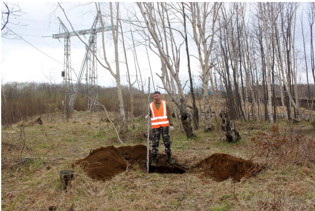
Рис. 10. «Объездная дорога от Петропавловское шоссе до жилого района «Северо-Восток». Строительство объездной дороги от проспекта Циолковского до Северо-Восточного шоссе (объезд Северо-Восточной части города)». Шурф № 1. Общий вид шурфа с выбранным заполнением (вид с востока).
