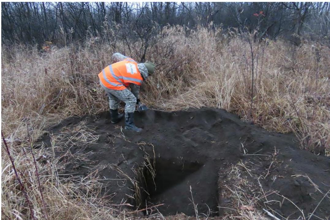
Рис. 48. «Обустройство поисково-разведочной скважины К. Кеткинского лицензионного участка. Этап 2». Шурф № 6. Рекультивация шурфа (рабочий момент; вид с юга).
